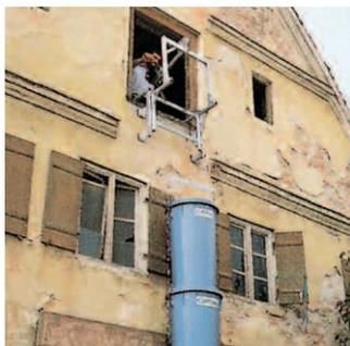
Crampon pour fixer le tuyau aux parapets et fenêtre, pos. 6
