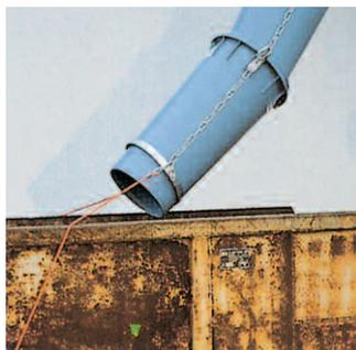
Fixation du dernier élément sur container grâce à l'anneau de guidage, pos. 14
