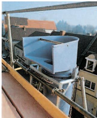
Facilité d'évacuation des déblais grâce à l'entonnoir (accessible avec la brouette), pos. 10
